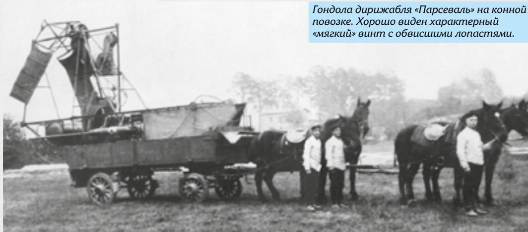
Гондола дирижабля «Парсеваль» на конной повозке. Хорошо виден характерный «мягкий» винт с обвисшими лопастями.
